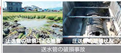
圧送管の破損による被害 圧送管の破損状況 送水管の破損事故
