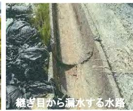
継ぎ目から漏水する水路
