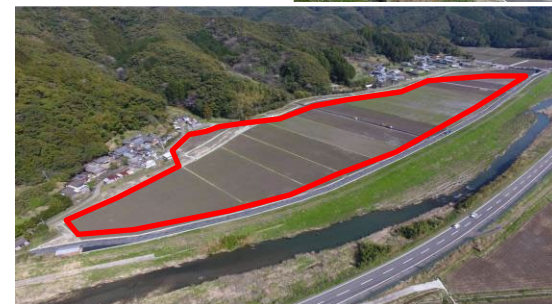
排水路の整備
