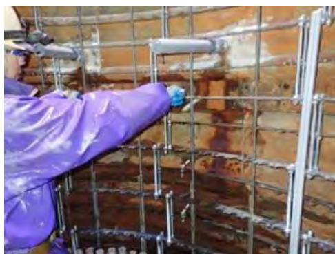
図 1-6-8-5 鋼製リング組み立て状況
