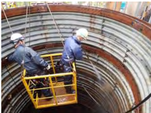
図 1-6-8-4 高圧洗浄状況
