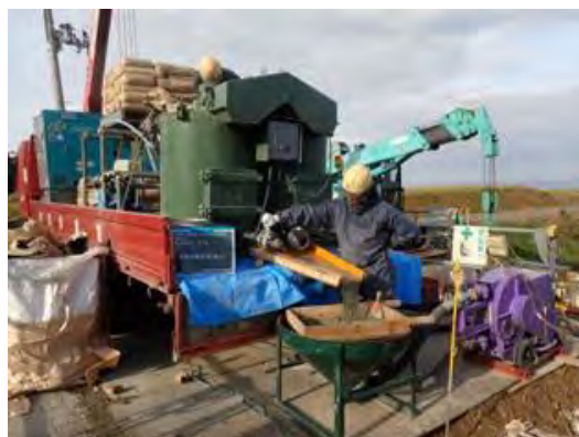
図 1-6-8-7 混練状況（地上プラント）
