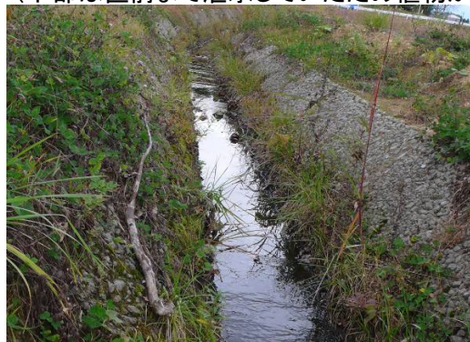
実証試験水路施工4年後 (植生工なし)
