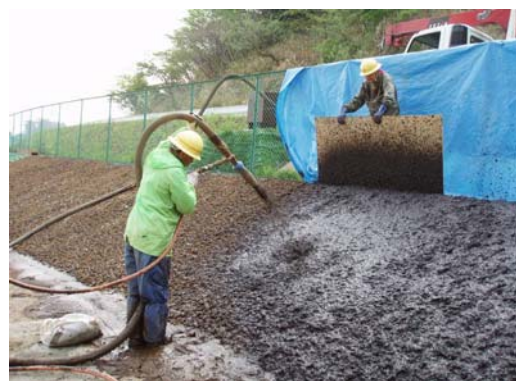
覆土・種子吹き付け
