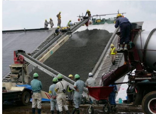
②テレベルトによる投入
