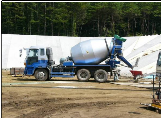
①アジテータ車による運搬
