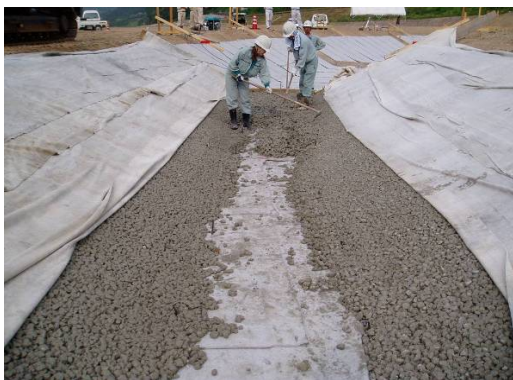
③投入、敷き均し
