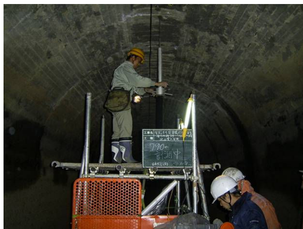
地山簡易貫入試験実施状況
