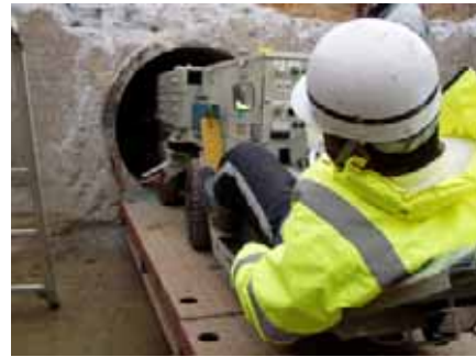
無軌道台車による搬送
