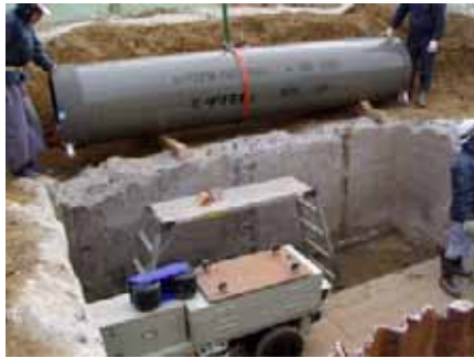
管の吊りおろし
