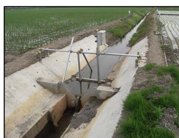
写真-3 排水路堰上げ井堰（左：堰高 80cm、右：堰高 50cm）
