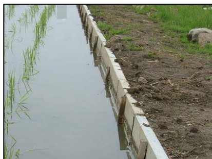
写真-4 畦畔止水パネル（左：18 年度試作、右：19 年度試作）
