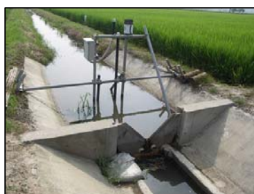
写真-3 排水路堰上げ井堰（左：堰高 80cm、右：堰高 50cm）
