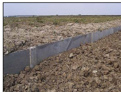
写真-4 畦畔止水パネル（左：18 年度試作、右：19 年度試作）
