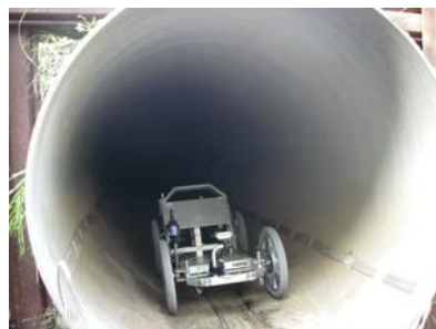
試験研究機関の埋設管による性能確認
