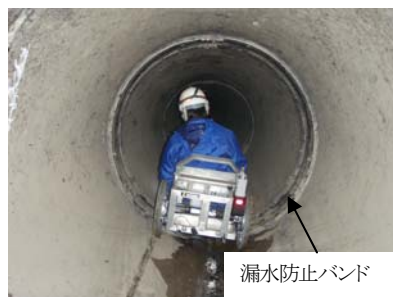
漏水防止バンドの乗り越え性能確認状況
