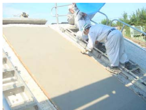
写真-9 模擬堤体による施工性試験の状況 (左：施工中の状況、右：施工後の状況)
