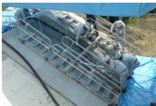
写真-9 模擬堤体による施工性試験の状況 (左：施工中の状況、右：施工後の状況)
