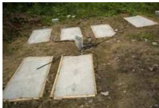
写真-7 植物の繁茂抑制効果の確認試験状況
