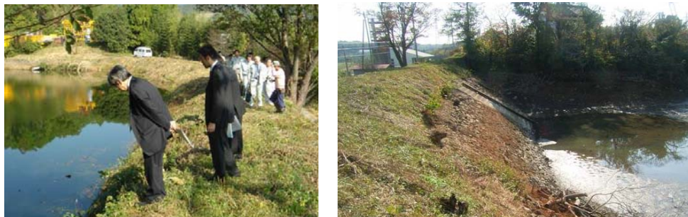
写真-10 向の池の状況（左：水抜き前、右：水抜き後）
