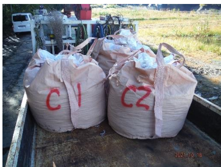
(e) 農業土木用改質土積込 (新潟)
