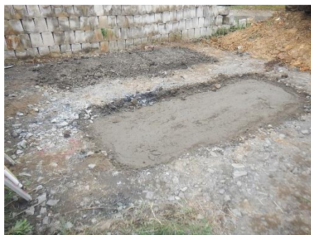
(s) 機能監視ヤード造成完了 (奥；模擬畑，手前；模擬農道)
