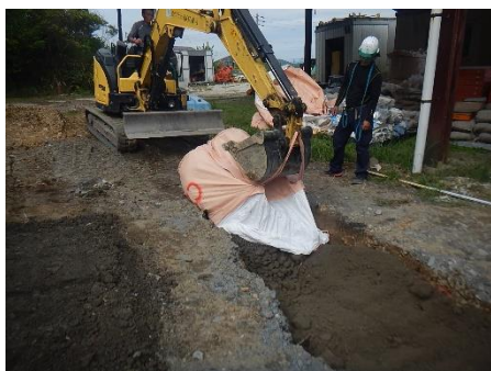
(q) 農業土木用改質土投入
