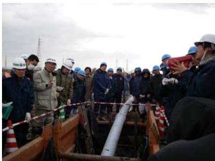
多くの見学者のもと、実証試験工事を行った。
