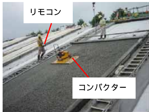
写真-6 コンパクターによる締め
