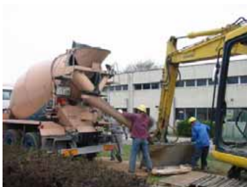
写真-2 アジテータ車による運搬および投入
