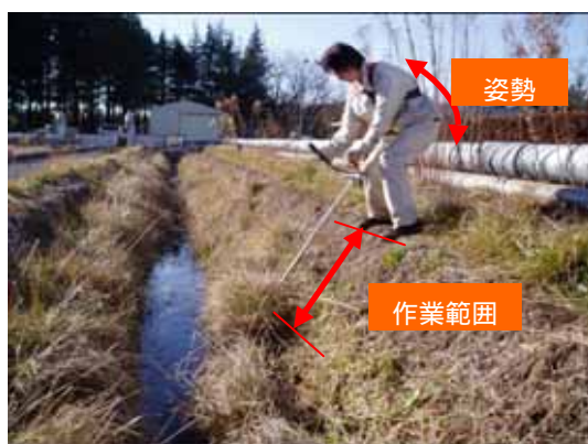
写真-8 法面上部からの草刈
