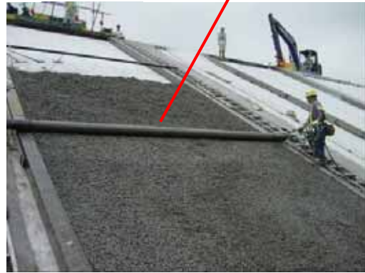
写真-5 ストライカーチューブによる敷き均し
