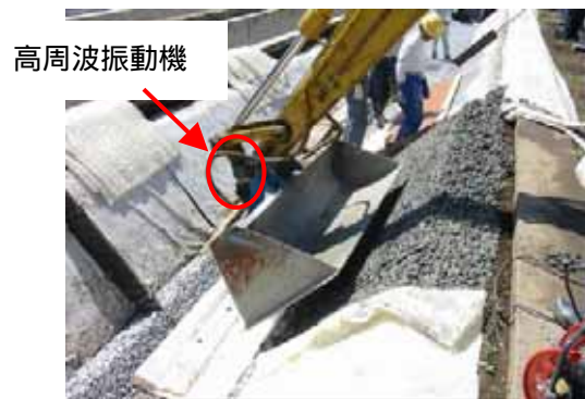
写真-3 高周波振動機付バケットによる締固め
