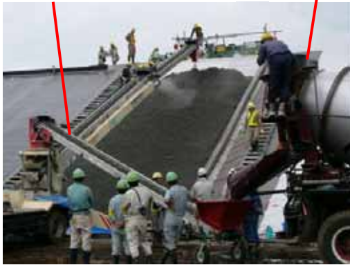
写真-4 可搬式ベルコンによる投入
