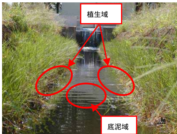
写真-7 ポーラスコンクリート水路の調査位置
