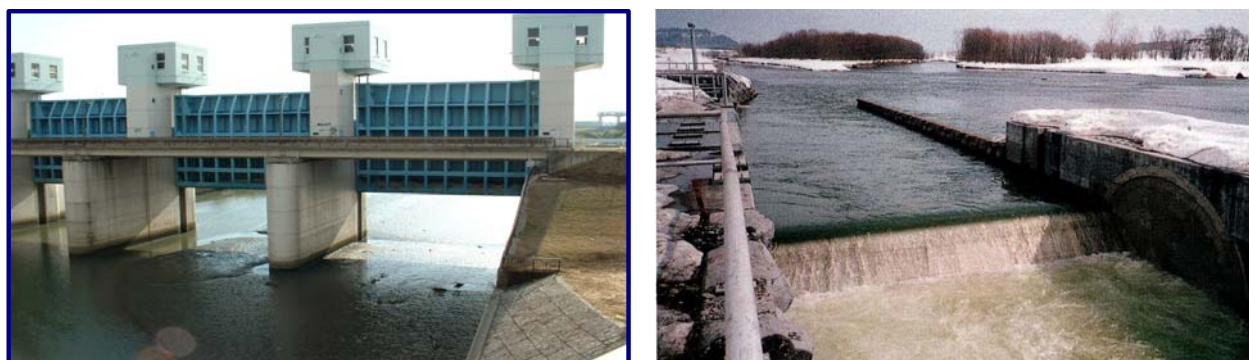
図13 設置状況（左：一般的なゲート 右：北海道 永山取水ゲート）
