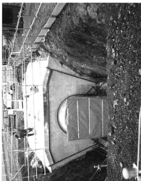
PCa型枠の設置状況
