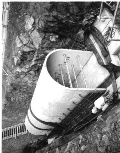
設置が完了した PCa型枠
