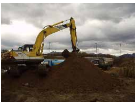
堤体土掘削 ( w_n=13.7\% )
