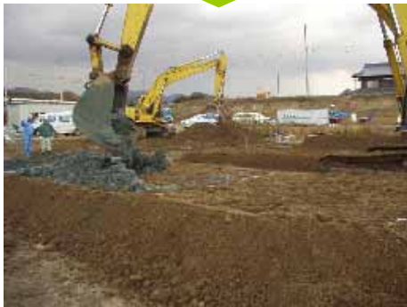
底泥土の撤き出し
