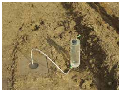
透水試験状況
