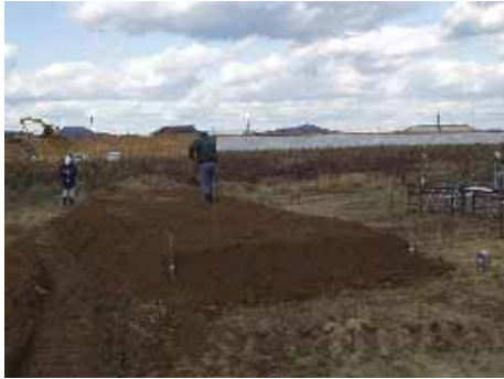
堤体土の撤き出し
