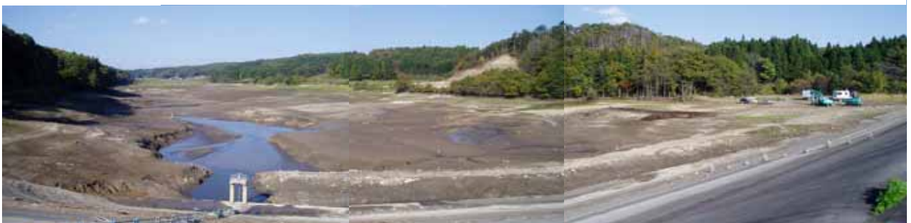
堤体より池全景を望む（落水後）
