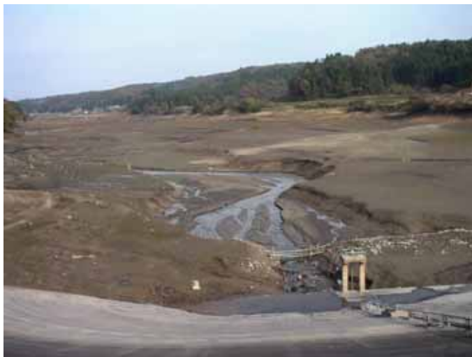
写真 - 2 澇筋に沿った底泥土の堆積状況
