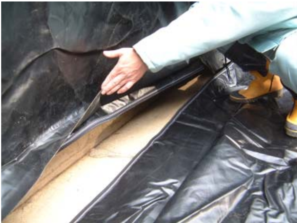
写真 4 壁部シートと底部シートの接合チェック
