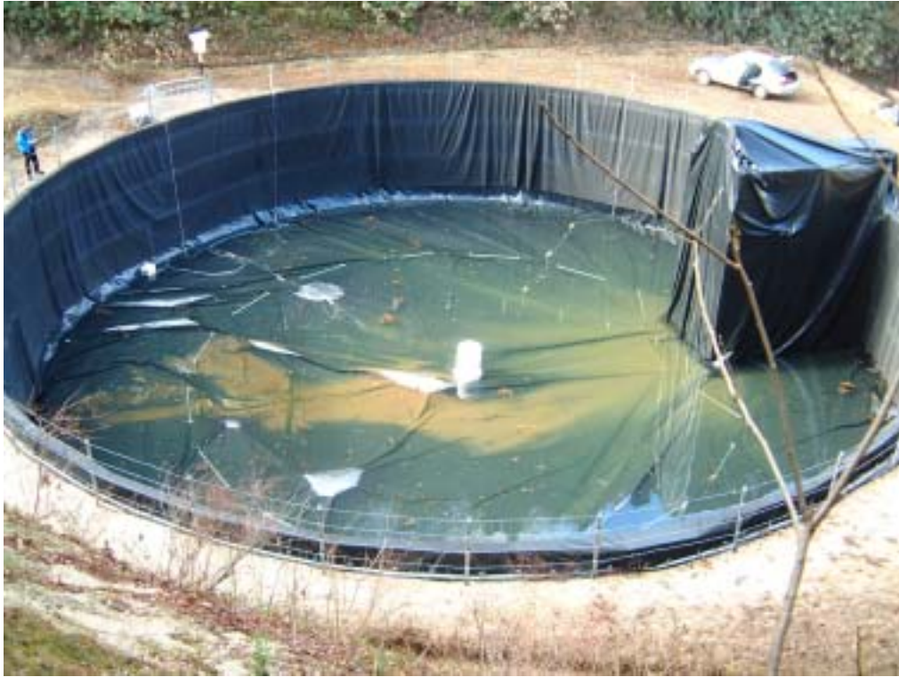
写真 - 5 封水 (シート上水) 注入 ; 20 c m 深
