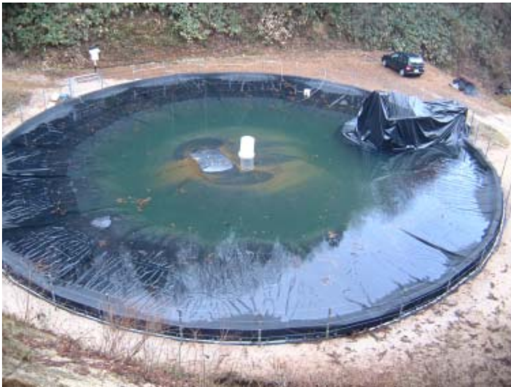
写真 - 6 天蓋設置完了 (満水完了後)
