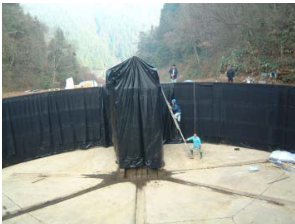
写真 2 ファームポンド壁部シートおよび取水塔シート架設
