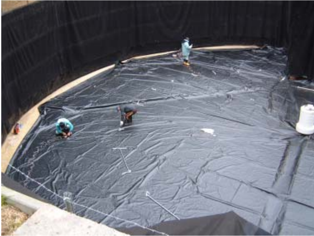
写真 3 底部シート敷設と錘の取付け
