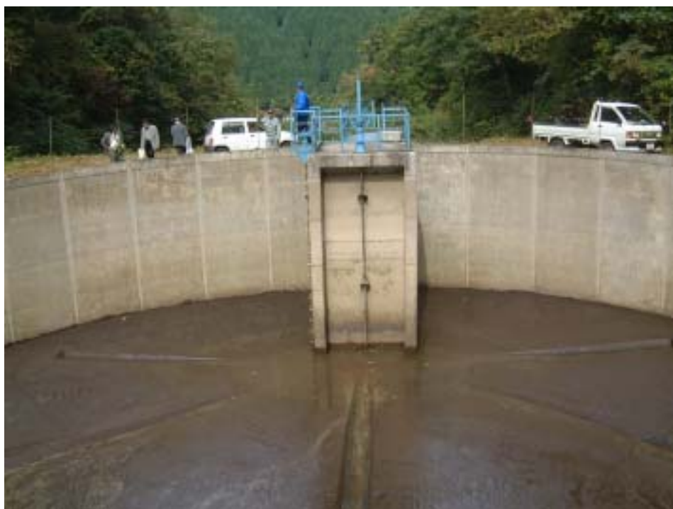
写真 1 ファームポンド現況（天蓋取付け前）
