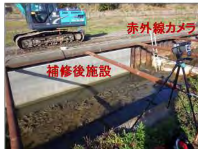
図-19 赤外線カメラ設置状況
