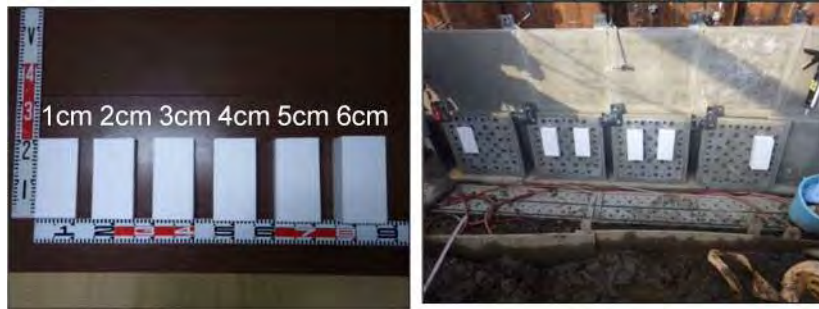
図-16 人工欠損用発泡スチロール（厚さ 1cm～6cm）の設置状況
