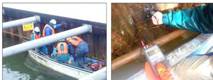
図-2 超音波板厚計による残存板厚調査
