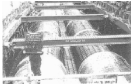
ジオグリッド(下層)敷設
