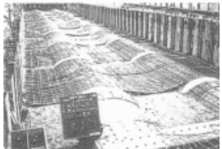
ジオグリッド(上層)敷設
