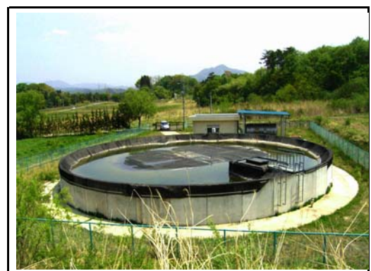
⑥天蓋完成状況
