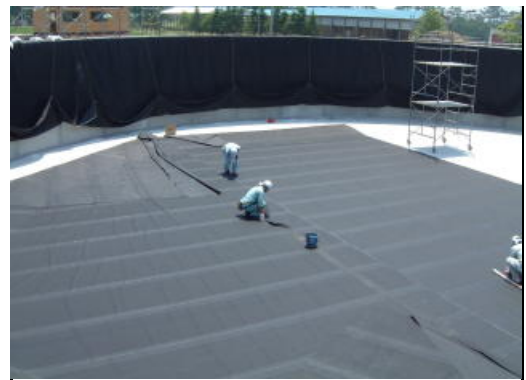
④天井シートの設置
