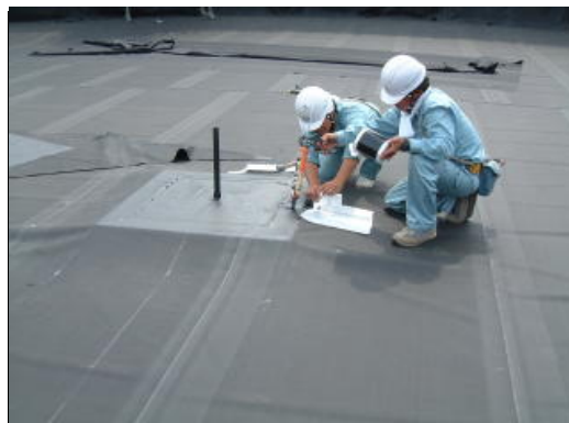
⑤エア抜きフロートの設置
