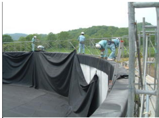
③壁部シートの設置
