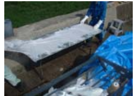
接着シート工
