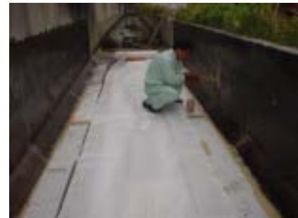
プライマー塗布工
