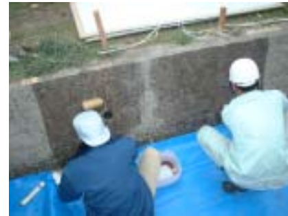
プライマー塗布工
