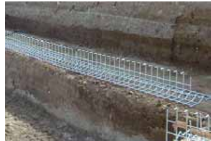
写真-1 壁面材設置
