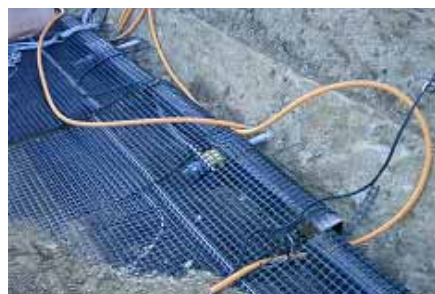
写真-5 ジオグリッド, アンカー接続
