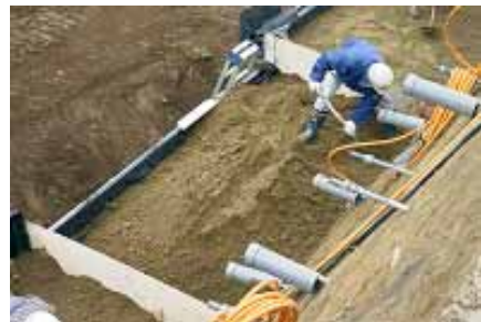
写真-3 撒き出し, 敷均し
