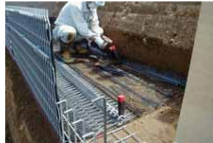
写真-2 ジオグリッド敷設
