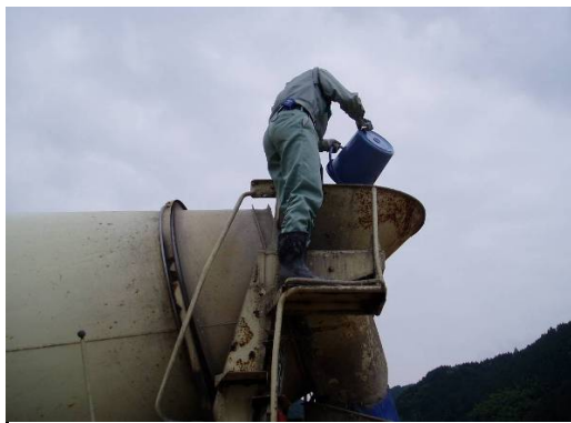
②アジテータ車による生コンクリート運搬、現場で特殊混和剤を投入し練り混ぜ
