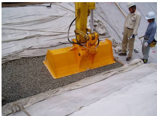
④高周波振動機付きバケットによる振動締固め
