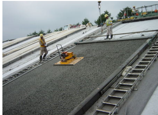
④コンパクタによる振動締め固め
