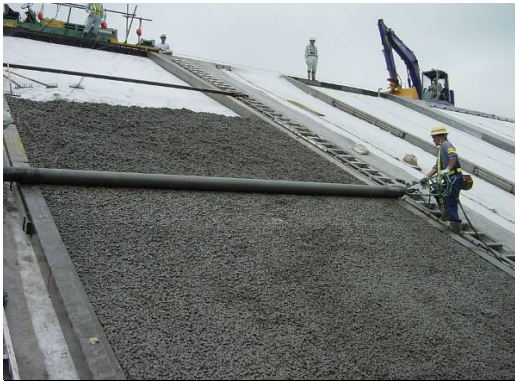
③ストライカーチューブによる敷き均し
