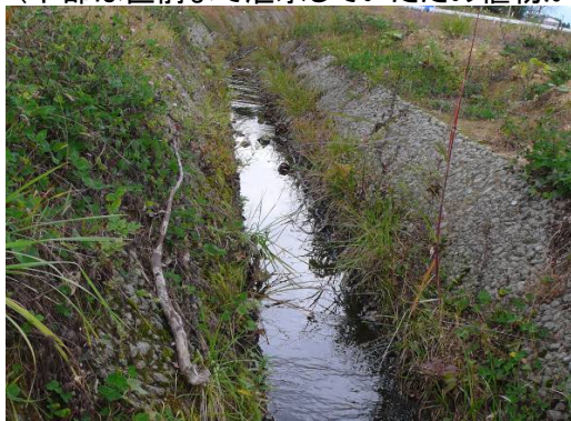
実証試験水路施工4年後 (植生工なし)
