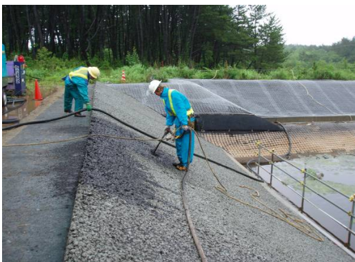
自然土壌による土壌充填
