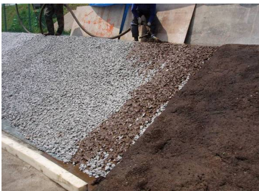
自然土壌の充填(写真)、覆土・種子吹き付け (東京都内事例)
