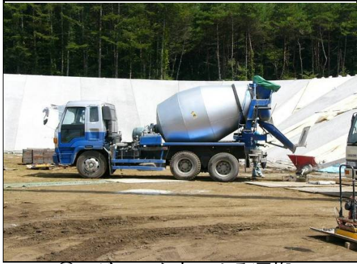
①アジテータ車による運搬
