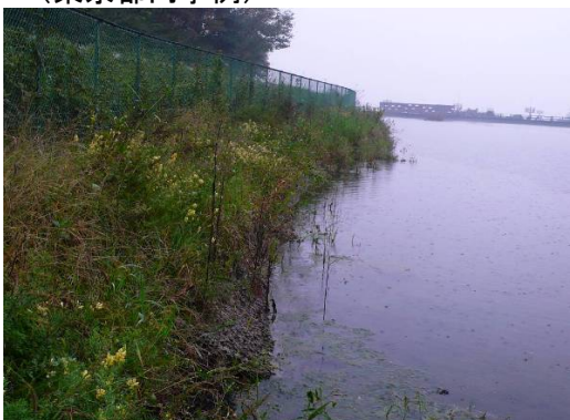
施工3年半後(上記東京都内事例)
