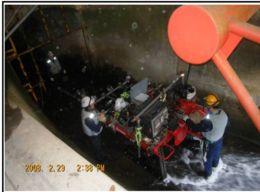
③自走台車の水路内への投入状況
