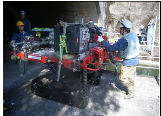
②自走台車の現場投入状況
