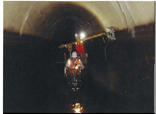
②レーダ計測状況
