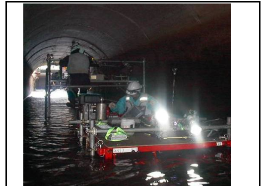
④自走台車による減量通水調査（レーザー計測）
