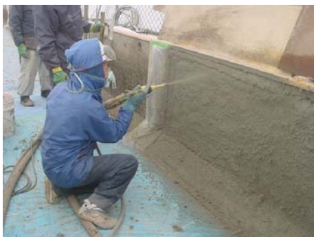
写真-10 吹付け施工状況
