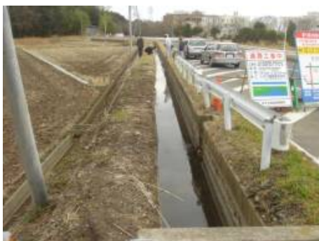
写真－8 試験施工箇所（茨城県）
