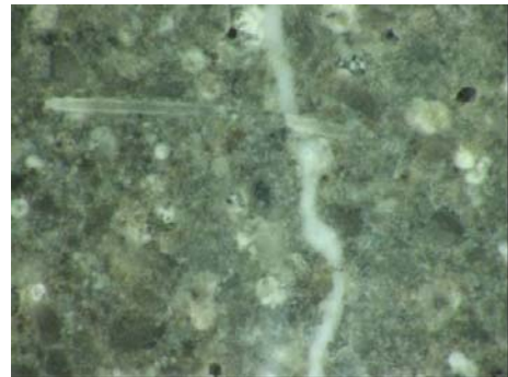
写真－4 ECC ひび割れ部の目詰まり状況
