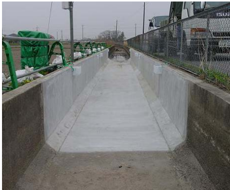
写真-9 実証試験箇所全景
