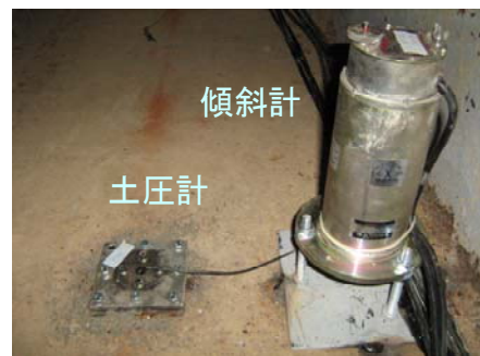
図-5 土圧計・傾斜計設置状況
