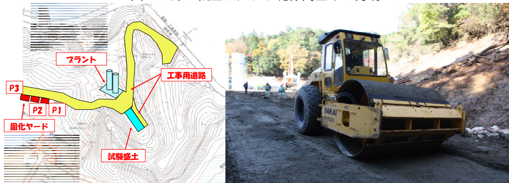
図7 大原ダムにおける実証試験
