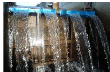
写真-6 樋型の流
