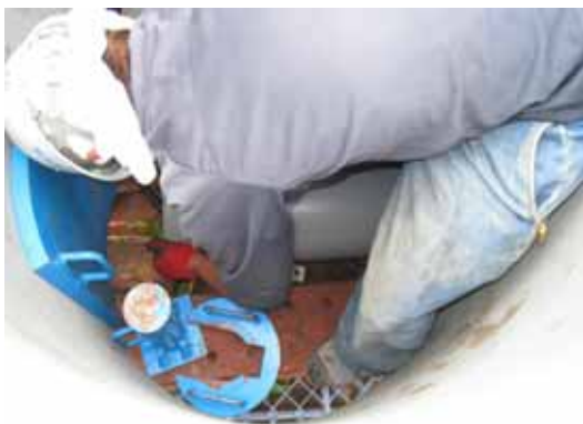
写真 6 15 ファイン管の接続
