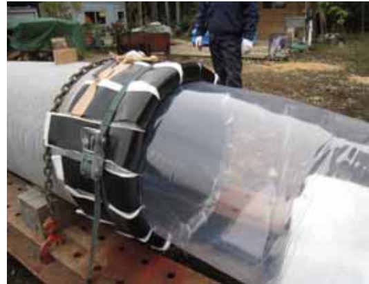
写真 6 12 拡径作業
