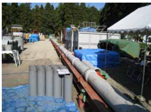
写真 6 7 施工状況 (L = 50m)
