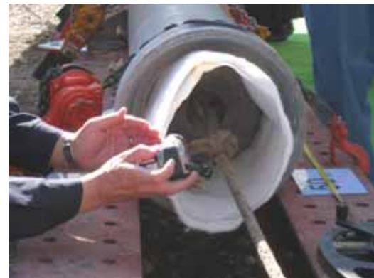
写真 6 6 最終管抜け出し
