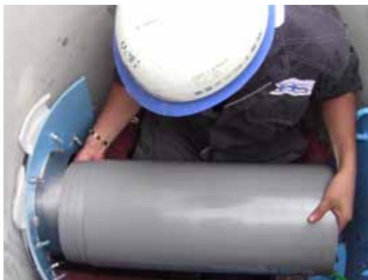
写真 6 13 先導管設置
