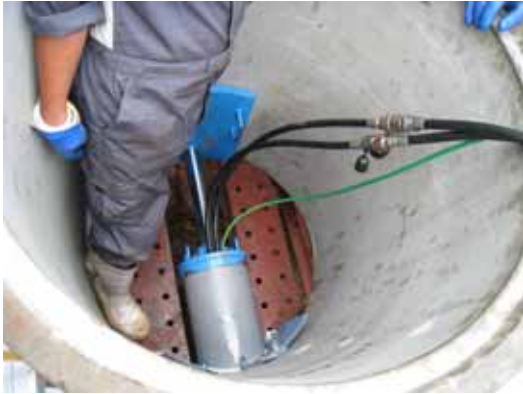
写真 6 17 ファイン管用推進機械にて推進
