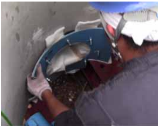
写真 6 11 F M材の固定
