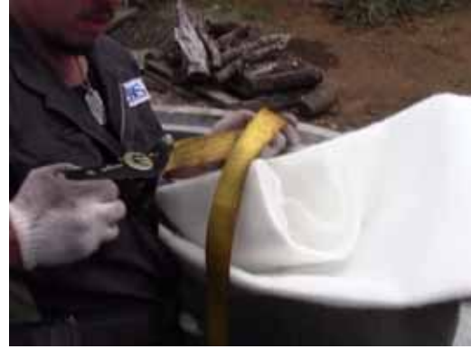
写真 6 10 F M材 引き込み段取り
