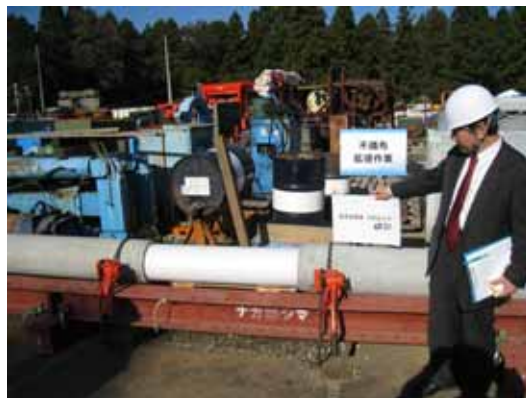
写真4 - 3 F M材の拡径作業
