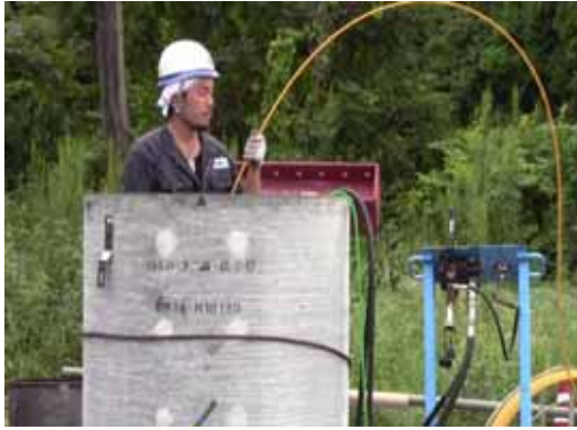
写真 6 9 F M材 引き込み段取り
