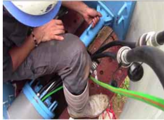
写真 6 18 ストラット設置
