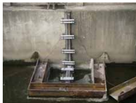
図-1.6.6 局所締切装置設置状況
