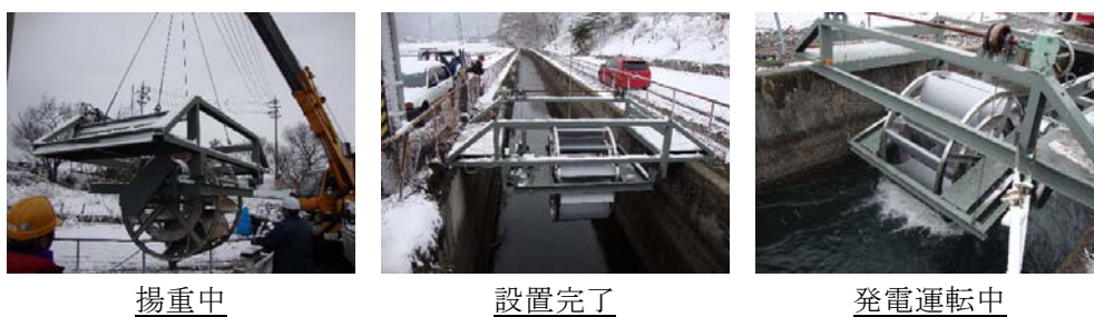
図-5:平成21年度施工状況写真
