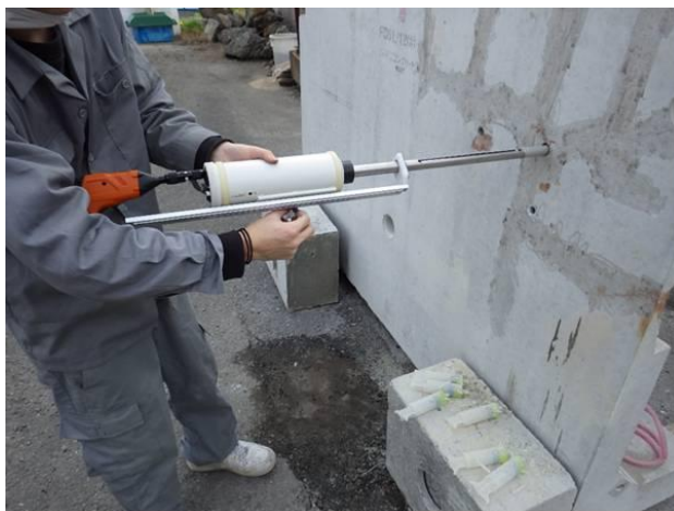
写真-1.7.8 注入状況の確認風景
