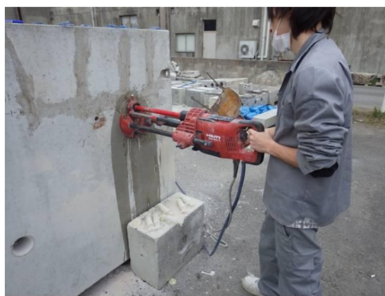
写真-1.7.7 削孔風景
