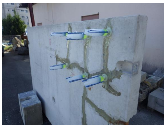
写真-1.7.6 ひび割れ注入工
