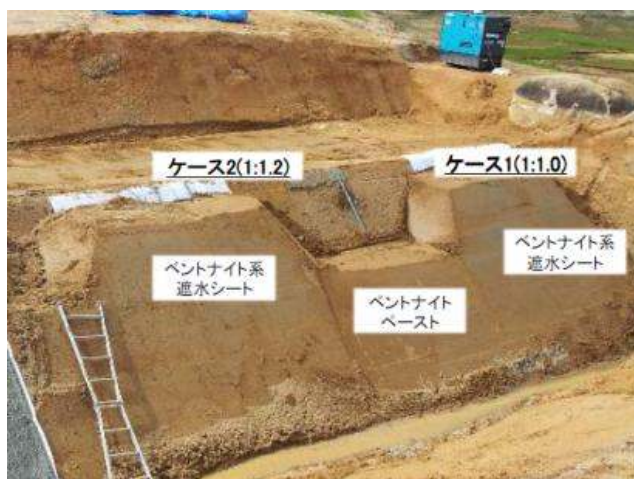
写真-2 ベントナイト系遮水シート敷設後状況
