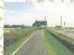
④ 明治用水赤松分水工
