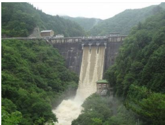
【平成30年ダム洪水放流の様子】
