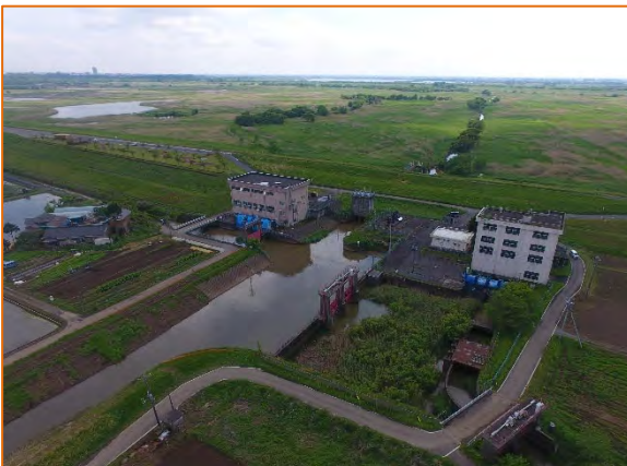
与良川第 1・第 2 排水機場
