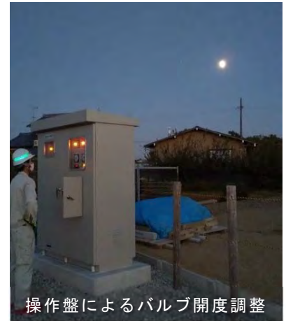
改修・新設の分水工での通水確認
