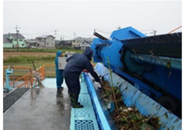
【除塵機での除塵作業】
