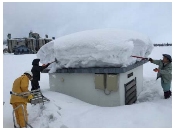
豪雪地帯ならではの除雪の苦労。除雪を怠ると屋根がつぶれてしまいます。
