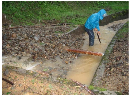
豪雨の影響で水路に入った土砂や雑木を手作業で撤去しました。
