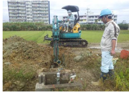
補修工事には監督員として立合い
