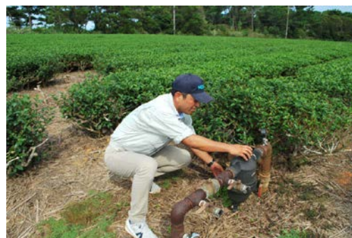
給水栓の目詰まりを解消
