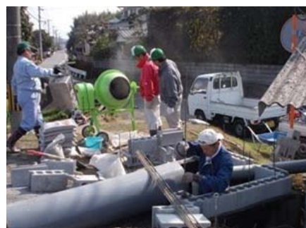
組合員による排水管の据え付け状況
