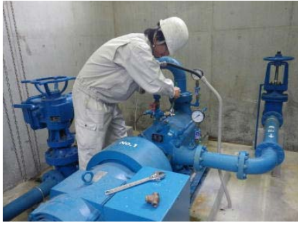
ポンプ点検作業
