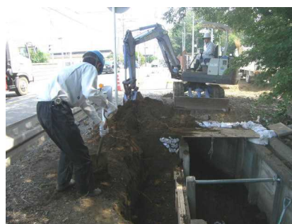
職員による水路補修
