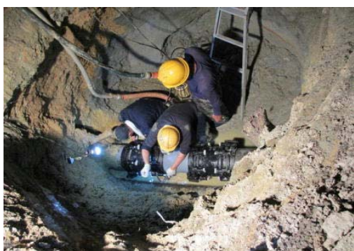
修復作業は夜遅くまで続いた
