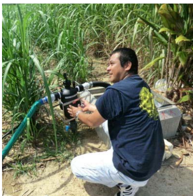
かんがいチューブの設置の説明をする 島主事（給水栓には赤字で曜日が記入）
