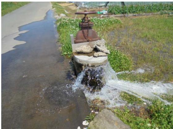
補給水用の用水施設が破損し漏水
