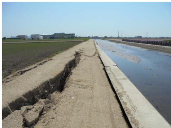
護岸沈下により管理用道路に生じた亀裂
