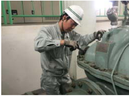
ポンプ点検作業中の荒岡さん
