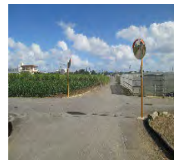
カーブミラー設置
