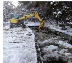
重機による氷塊除去
