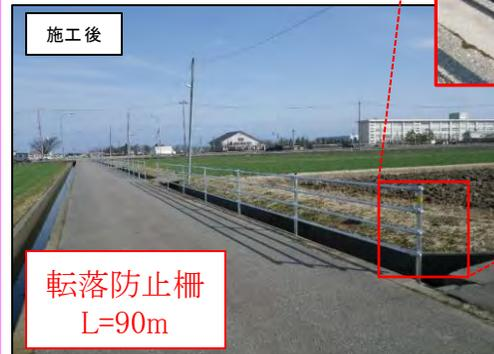
＜隣接道路管理者と協議し、転落防止柵設置と道路拡幅を合わせて施工した事例＞
