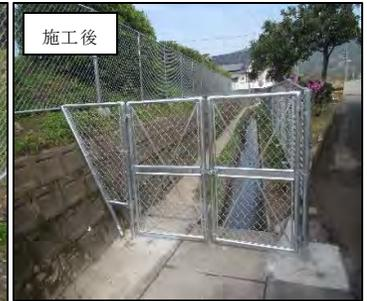
くため池への転落防止柵の設置と併せ、張コンクリートによって維持管理コストを省力化した事例 > 施設管理者：伊佐市
