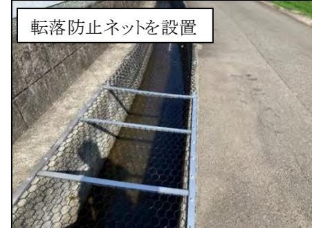
＜住宅化が進んだ地域で、町道に隣接した水路に転落防止柵を設置した事例＞
